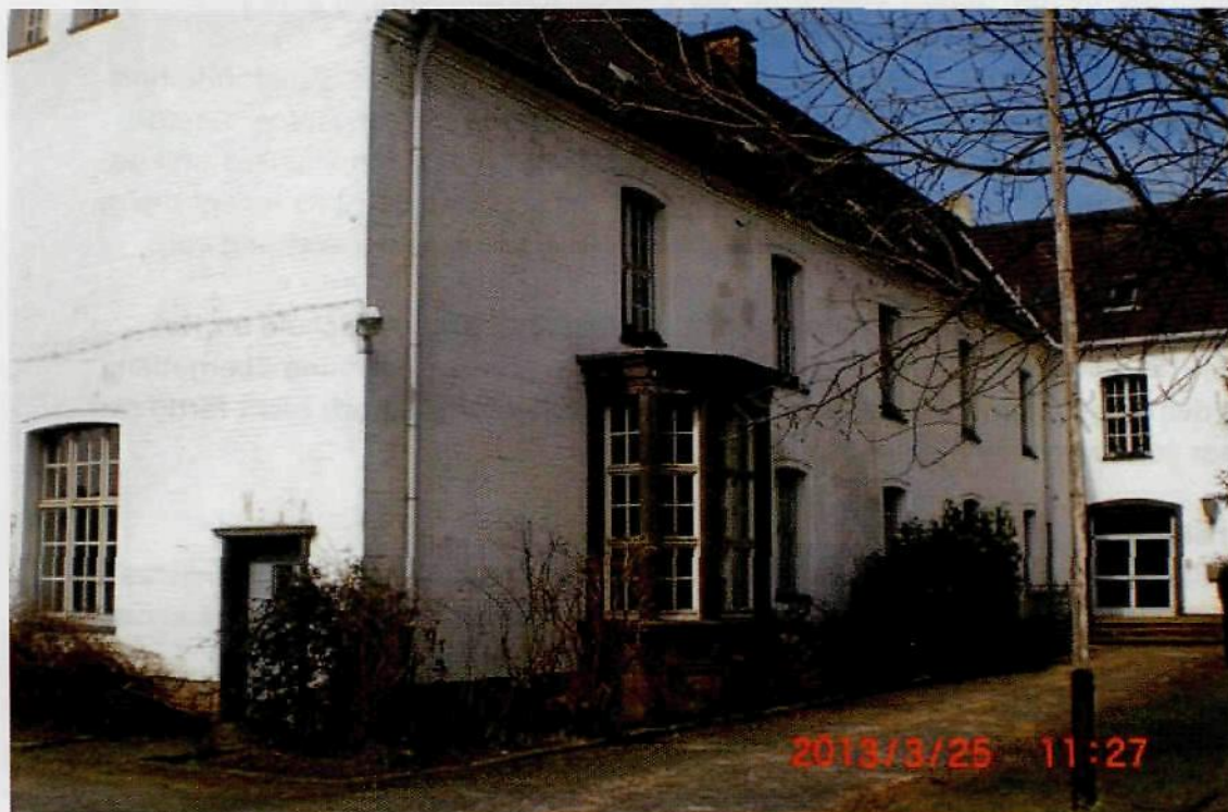
Schulgebäude, Ansicht von Südost (Foto: Köhren-Jansen)
