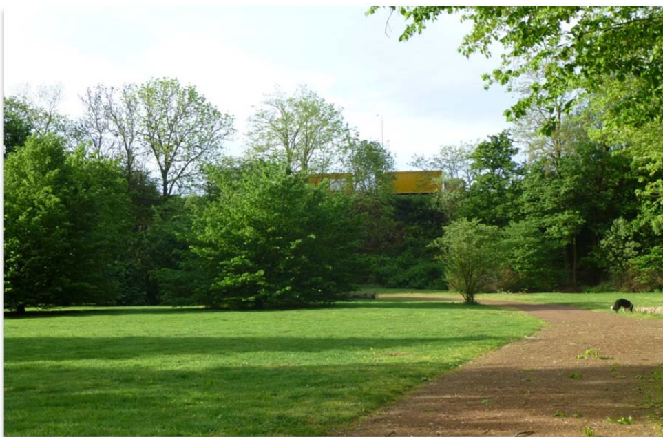
Bundesstraße (B 288) auf Dammkrone - Eigene Aufnahme
