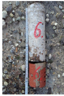
Bohrkern Nr. 6 aus Mau- erwerk und Beton (43 cm)
