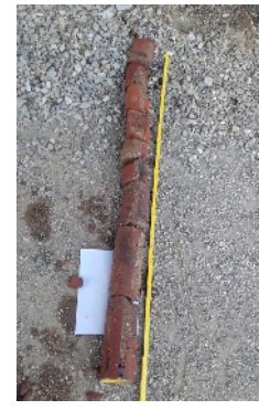
Bohrkern Nr. 3 aus Mau- erwerk (160 cm)
