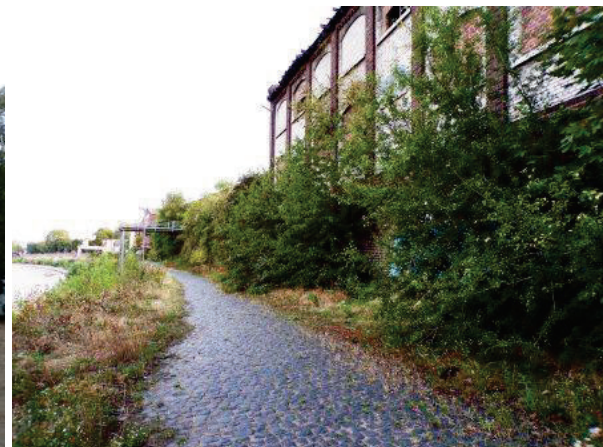
Bild 10: Halle im Süden des UG
