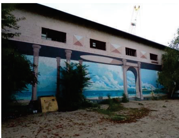
Bild 9: Halle im Süden des UG
