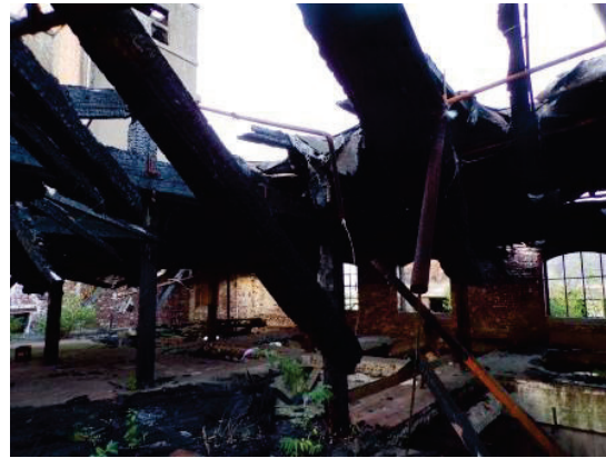
Bild 22: Dachstuhl Howinol Fabrikruiene
