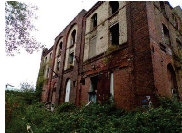
Bild 18: Mauerspalte, Tiefe ca. 3 cm
