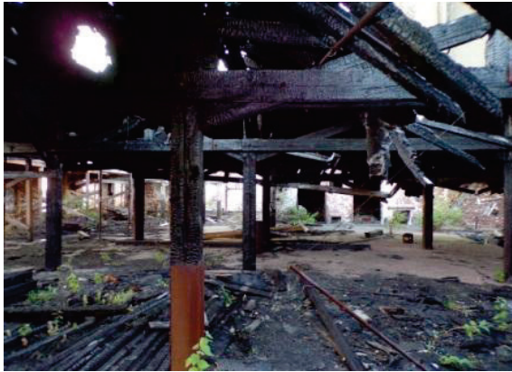
Bild 21: Dachstuhl Howinol Fabrikruiene
