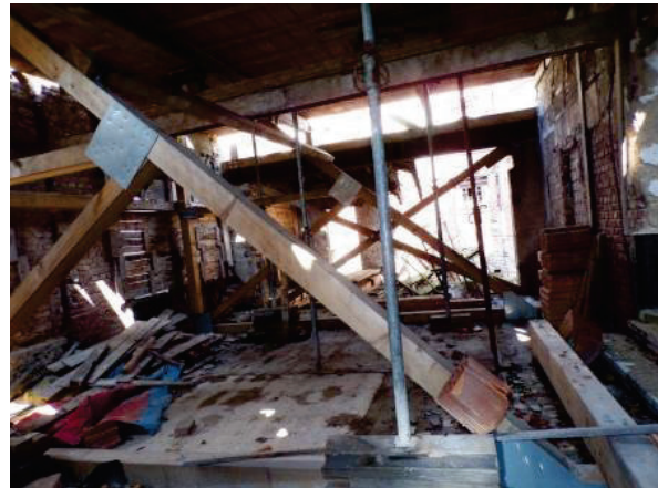
Bild 16: Howinol Fabrikruiene, Innenansicht
