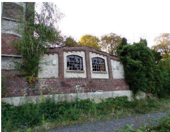
Bild 32: Gerätehaus der Villa, Rheinseite
