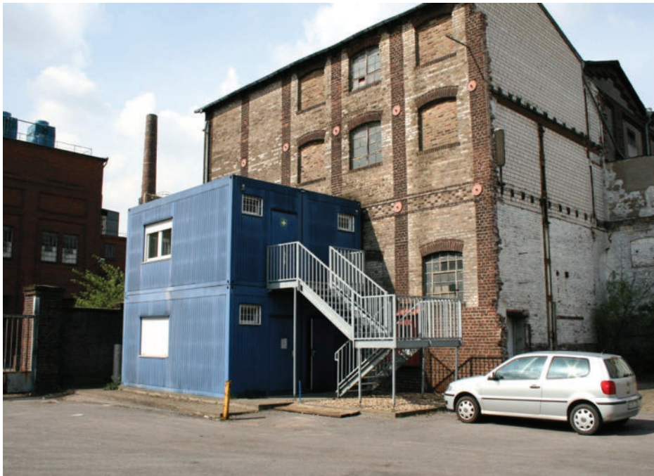
Abb. 5: Müncker-Grundstück: Standort der ehemaligen Abortanlagen mit RKB 19/BL 6
