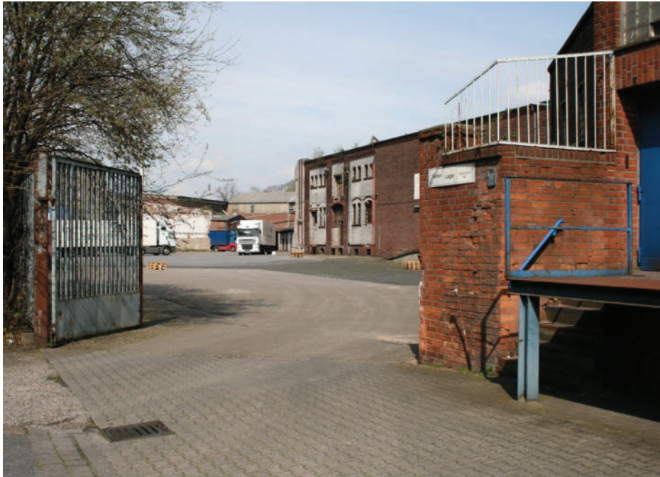
Abb. 3: Südliche Toreinfahrt Müncker: Bereich Kfz-Halle, Tankstelle, Waschplatz
