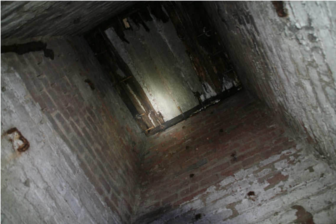
Abb. 21: Schacht zu den Kellerräumen
