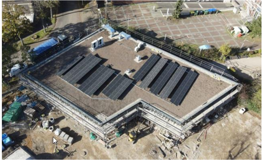
Neubau Errichtung PV-Anlage Prinz-Ferdinand-Schule
