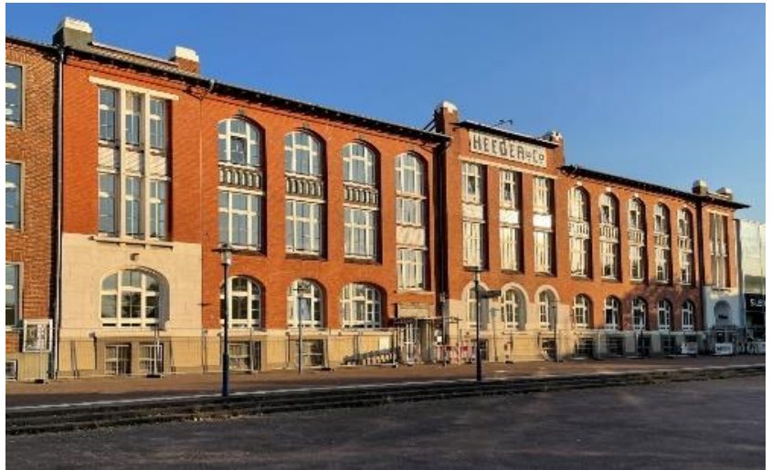
Fabrik Heeder, Innenhof
