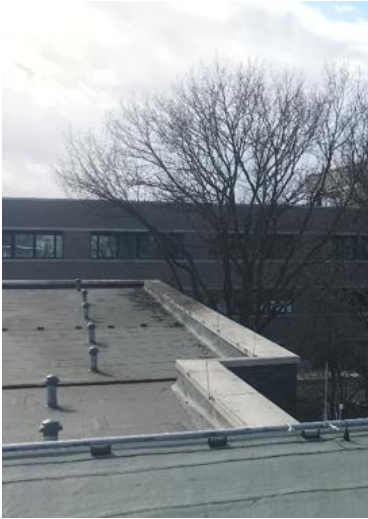
Dachfläche im Bestand
