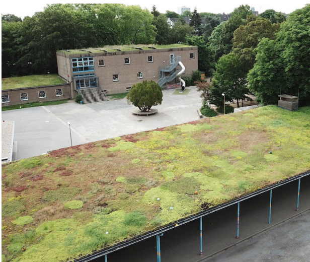
Blick auf das begrünte Dach der Bismarckschule an der Bismarckstraße.
